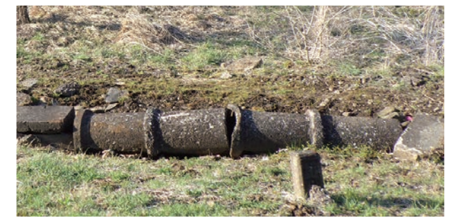
用排水路整備を実施
