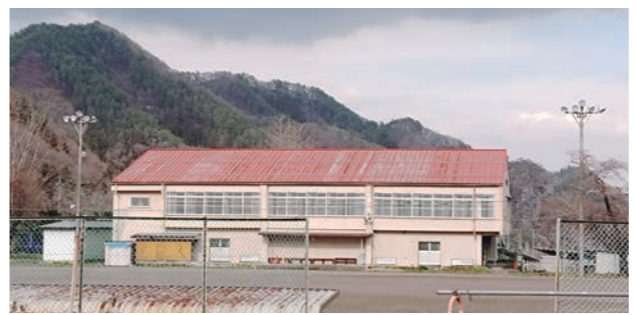
坂上小学校体育館を新設
