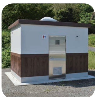
箱島湧水駐車場トイレ
