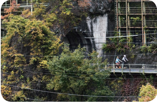
樽沢トンネルを抜けるアガッタン
