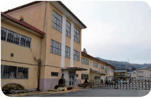
老朽化した旧岩島第一小学校
