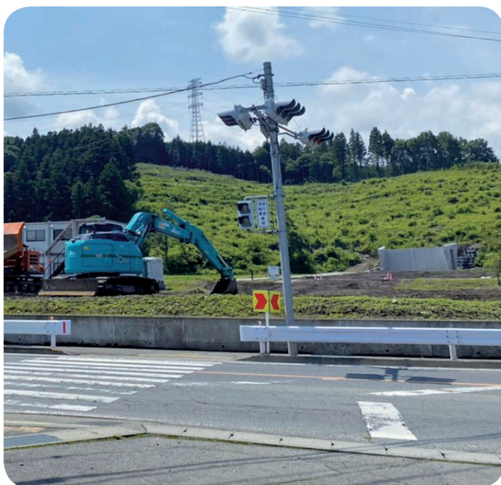
植栗・中之条インター設置予定地付近
