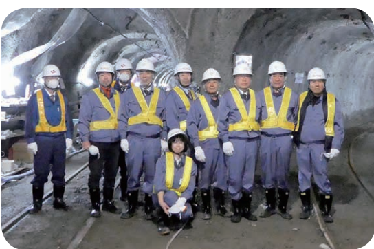
導水路トンネル内部
