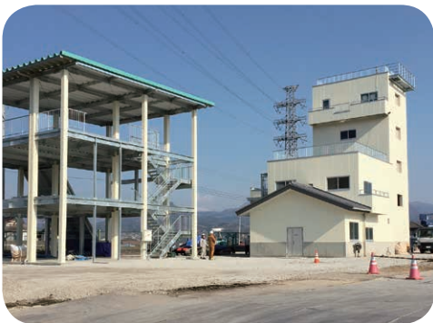
建設中の吾妻広域消防署
