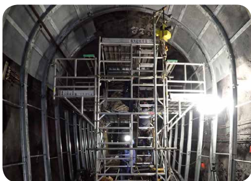
道陸神トンネル内部の補修工事の様子
