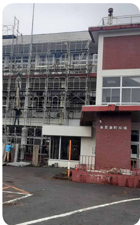
解体の始まった旧役場庁舎
