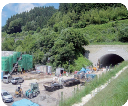
大柏木側、電気室棟の工事
