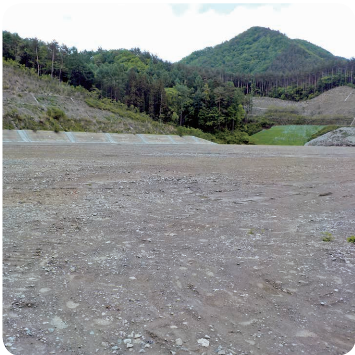
現在の大柏木プラントヤード跡地
