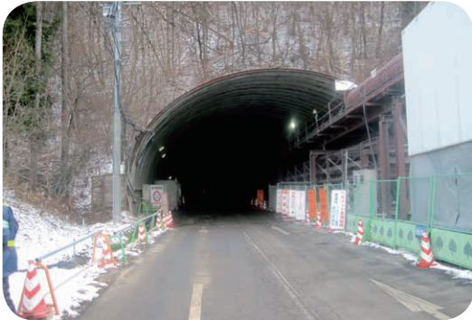
2021年度完成予定の大 柏木トンネル
