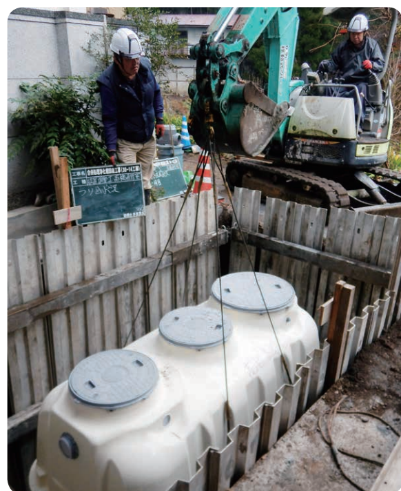
汚水処理の普及につながる合併浄化槽の設置
