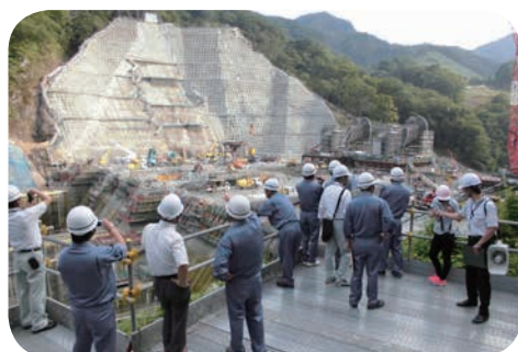
ハッ場ダム建設現場を視察しました
