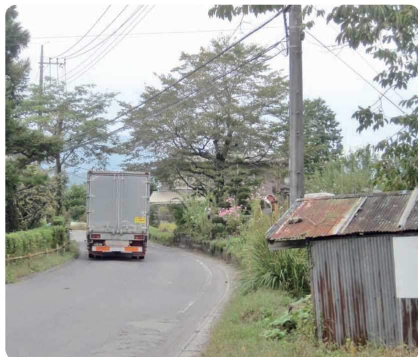
歩道がない町道金井・川戸線（浅間神社付近）
