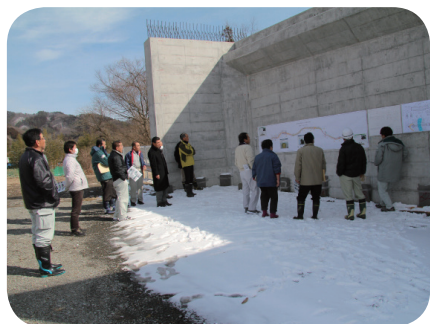
吾妻川大橋の工事現場を視察
