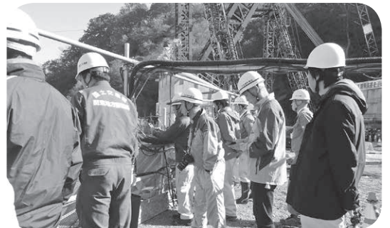
ハッ場ダム打設現場を視察
