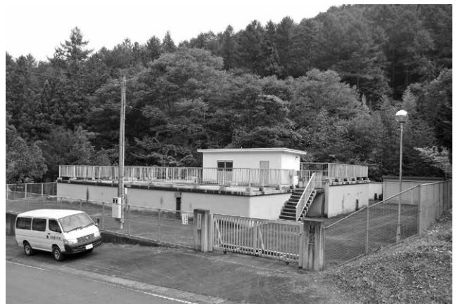
▲上水道（水道事業） 深沢配水池
