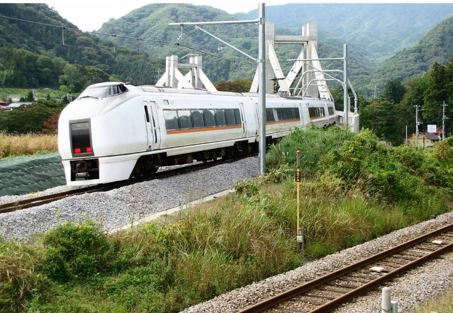
新ルートの新第二吾妻川橋梁（松谷・三島間）付近
