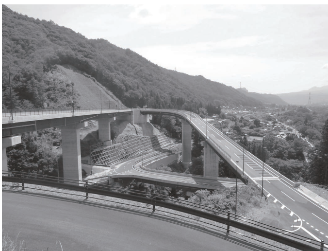
暫定供用された 雁ヶ沢ランプ
