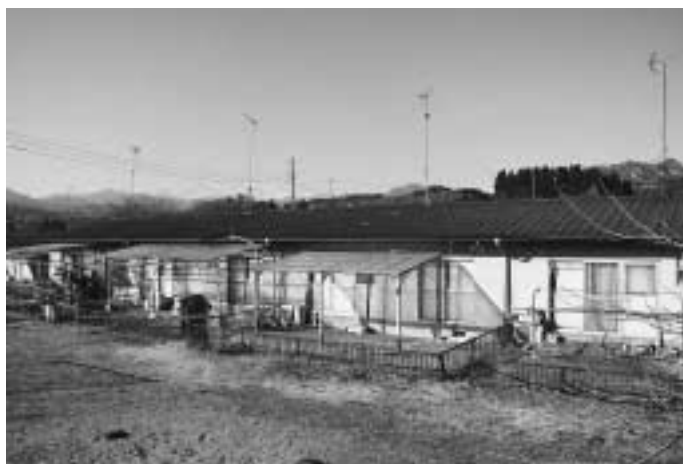
町民の安定定住と福祉のために (上河原町営住宅 太田地区)
