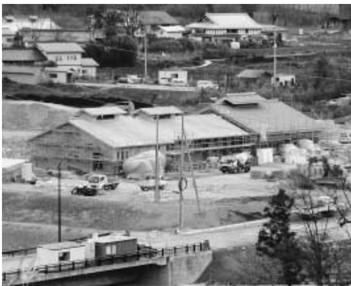
建設工事が進む健康増進施設「天狗の湯」
