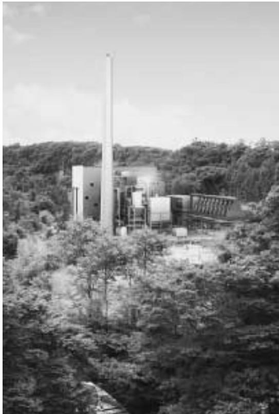
吾妻バイオパワー完成イメージ 地元雇用が期待される
