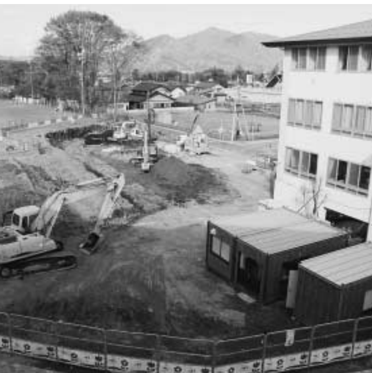
原町小学校プールの工事がはじまりました
