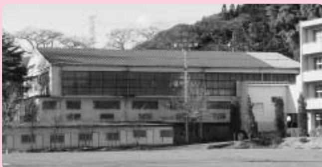
耐震診断をして 安全な体育館へ
