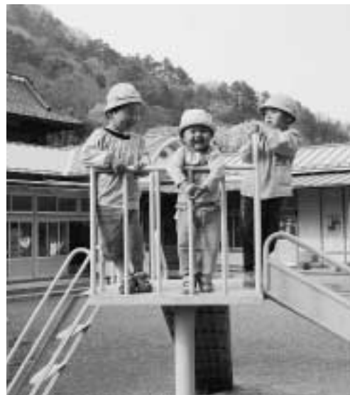
昭和34年に建てられた大戸保育所 細かな修繕を
