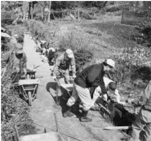
原材料支給を受け、水路の整備作業（岩下：天神区）
