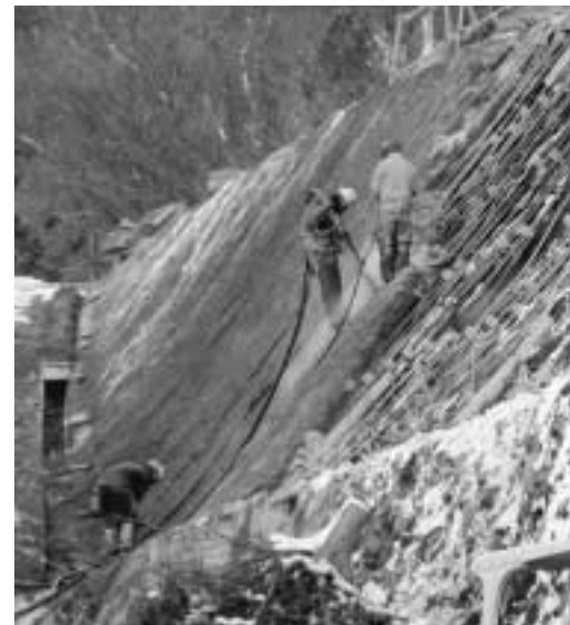
県道 林・東吾妻線の法面工事
