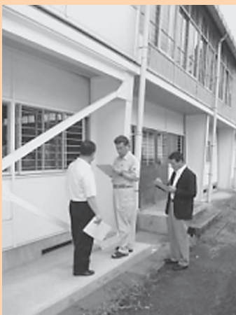
体育館耐震補強工事を現地調査しました
