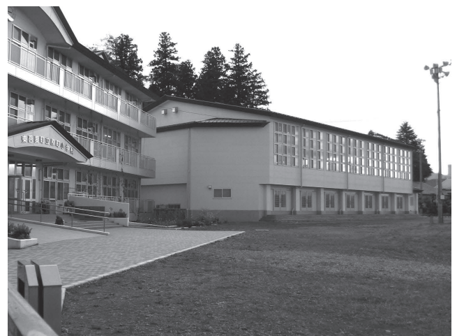
完成した原町小学校体育館
