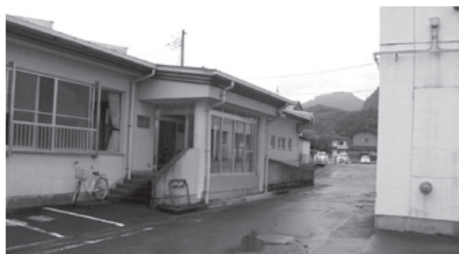
検診時には手狭な施設と、公民館と併用の駐車場
