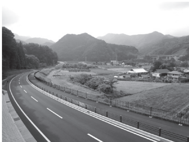
6月22日開通した三島地内 県道林岩下線
