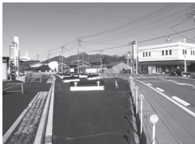
役場前の工事が進みました
