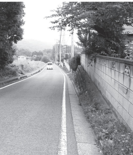
ある町道 9058 号線（岡崎柏原地内）
