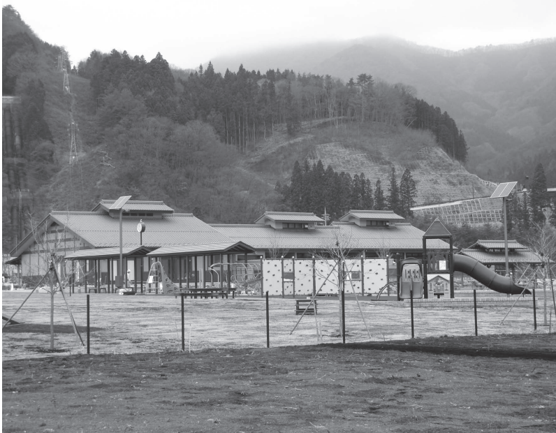
ふれあい公園の工事が着々と進んでいます
