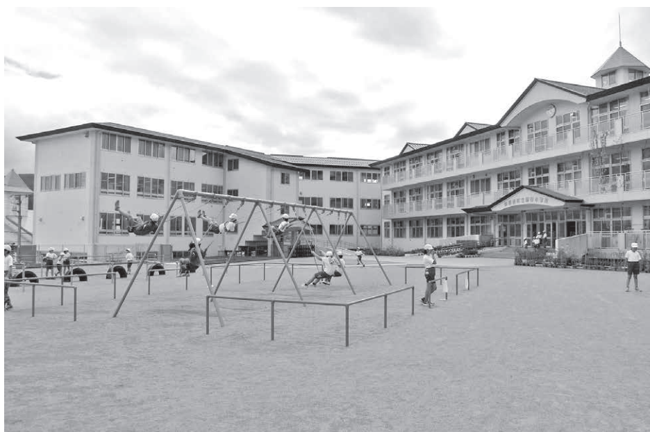
◀ 整地された原町小学校の校庭
