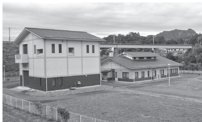
▲公共下水道 吾妻浄化センター
