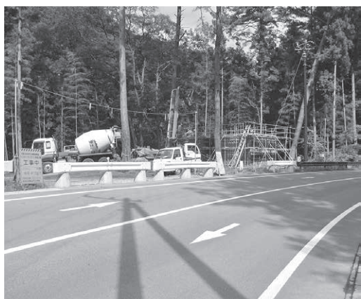
十二沢パーキング トイレ新築工事
