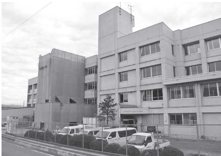
◀ 改修工事が行われている統合中学校（現原町中学校）
