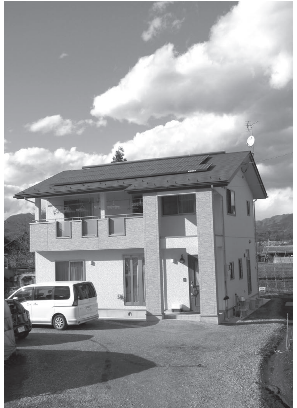
▲太陽光発電システムを設置している住宅
