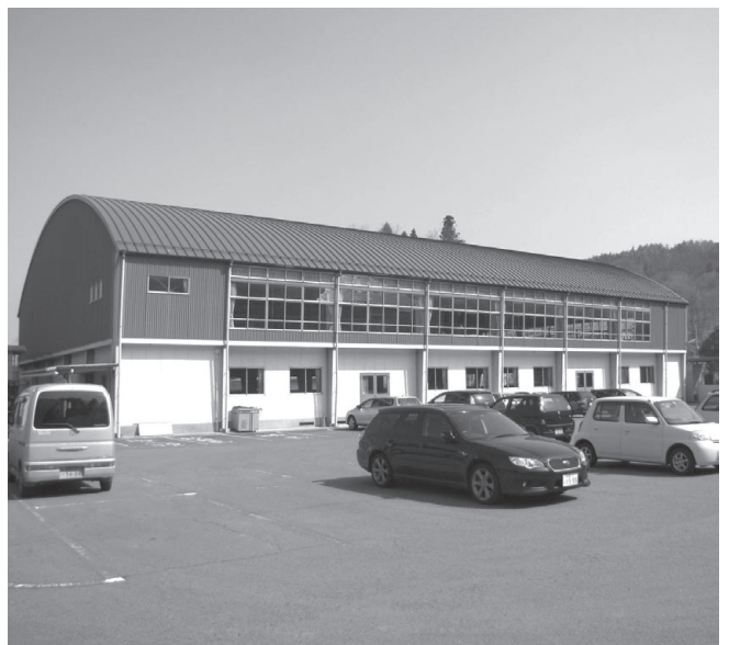
▼耐震補強工事を予定している奥田社会体育館
