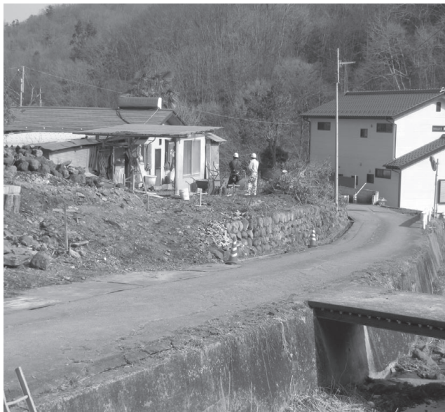
▼繰越事業となった町道内野・山田川線道路改良事業
