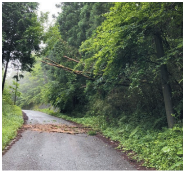
▲ 樹木が道路上空の電線に倒れたケース
