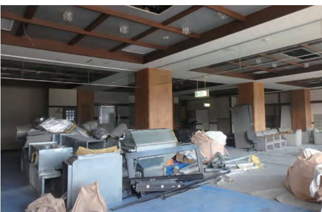
←増改築工事風景（内部）
