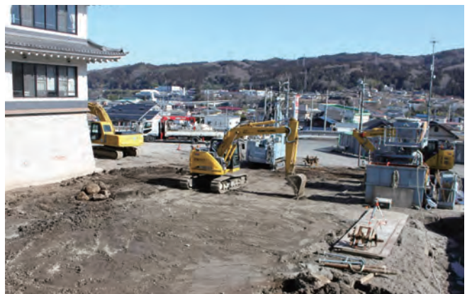
→増改築工事風景（外部）
