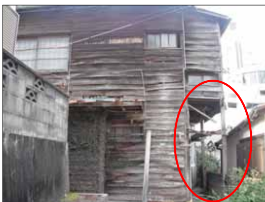
柱の数箇所に破損がある例
