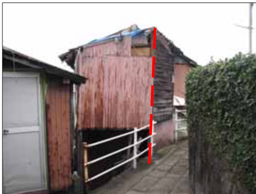
一部の柱が傾斜している例
