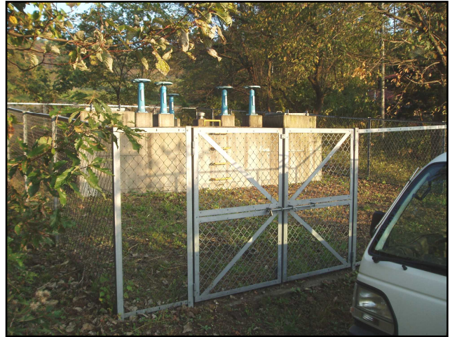
古賀良配水池
