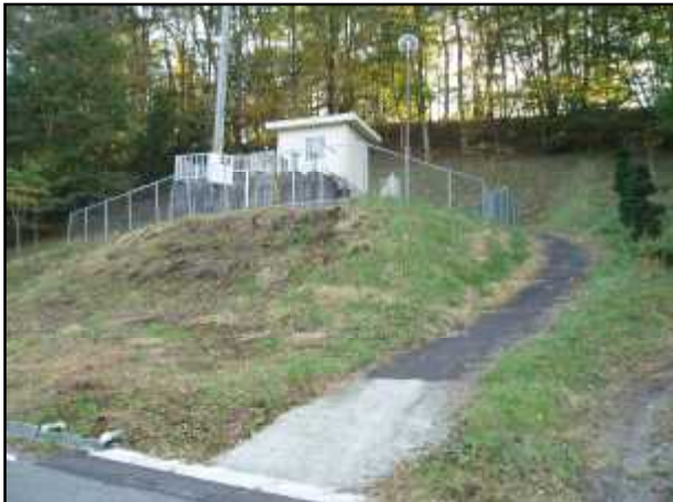
手子丸配水池
