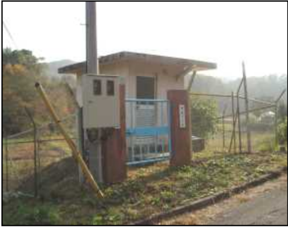
送水ポンプ室
