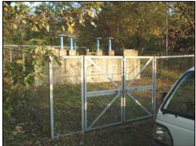
古賀良配水池
