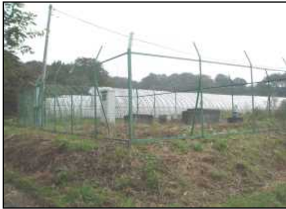
取水ポンプ場
