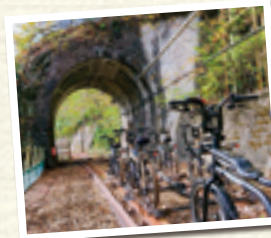
樽沢トンネル JR吾妻線の列車が通っていたH26年9月まで日本で一番短い(7.2m)鉄道トンネルでした。
