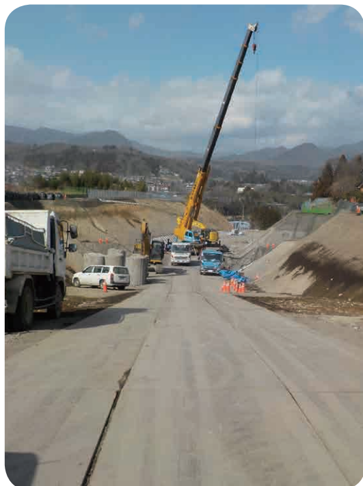
工事の進む県道植栗伊勢線
