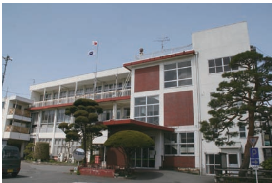
建築後60年が経過する現役場本庁舎
